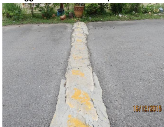
Gambar 1.13 Bonggol Jalan Dibina Tanpa Kebenaran
