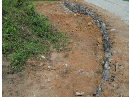
Gambar 1.7 Penyenggaraan Bahu Jalan
