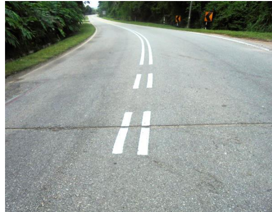
Gambar 1.10 Penyenggaraan Berkala – Mengecat Jalan
