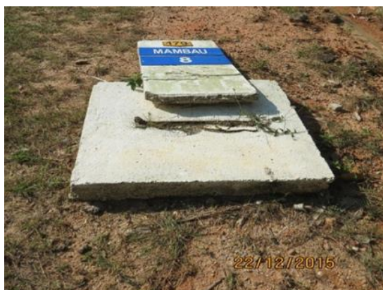
Gambar 1.3 Batu Penanda Jalan Patah
