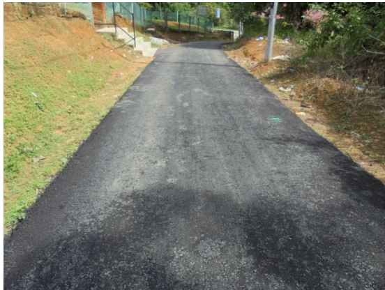
Gambar 1.11 Penyenggaraan Berkala – Turap Jalan
