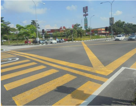
Gambar 1.9 Penyenggaraan Berkala – Turap Dan Mengecat Jalan
