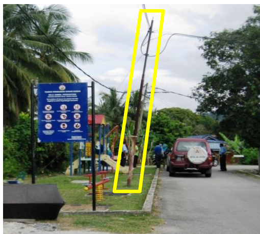
Gambar 3.9 Tiang Elektrik Dan Telefon Condong
